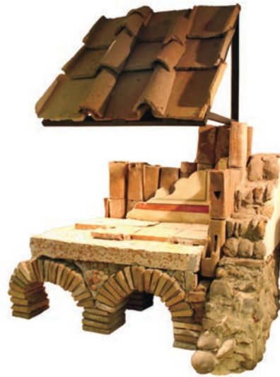
112. Model of floor and wall heating in the museum Lauriacum in Enns Modell einer Boden- und Wandheizung im Museum Lauriacum in Enns
