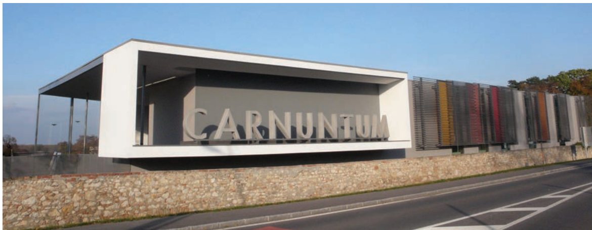
132. The entrance building to the Archaeological Park at Petronell-Carnuntum Das Eingangsgebäude zum Archäologischen Park in Petronell-Carnuntum
