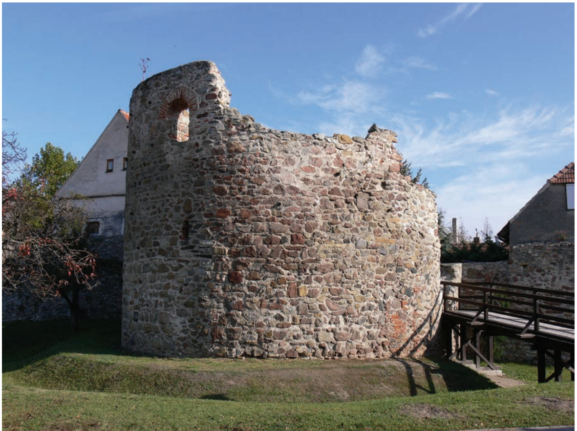
65. Fortification wall at the west front of the fort at Mautern with a U-shaped tower of Late Roman origin Die Befestigungsmauer an der Westflanke des Kastells von Mautern mit einem U-förmigem Turm aus spätrömischer Zeit
