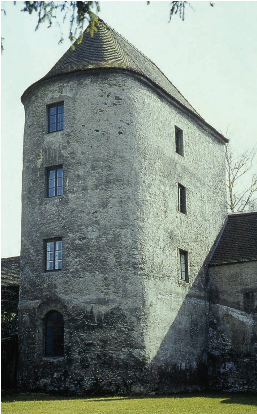
2. Intermediate tower at the north front at the late Roman fort of Traismauer Zwischenturm an der Nordflanke des spätantiken Kastells Traismauer
